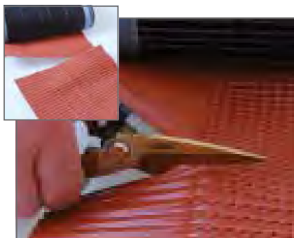
Řezání tenkého hliníku, zde např. pásu hřebene a nároží
