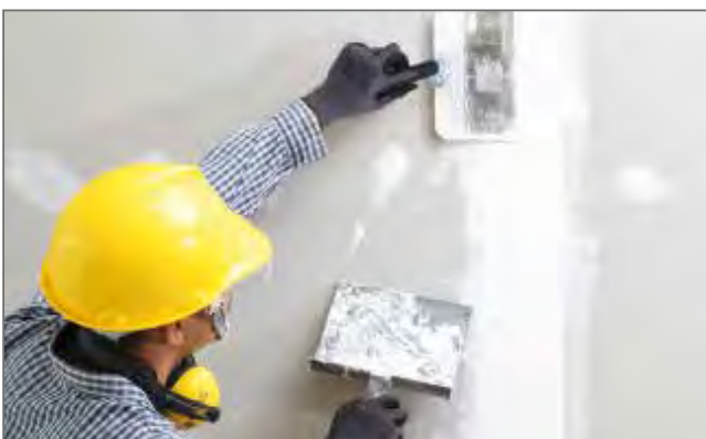
Suchá stavba/omítkařské práce
